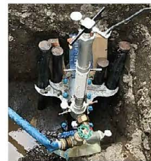
狭いスペースでも施工可能
