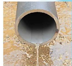
配管工事に支障のない止水性
